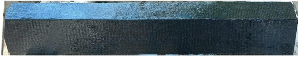
Hình 2.14 Lăn phủ lớp keo epoxy TCK 510R lần 2 lên bề mặt các dầm
