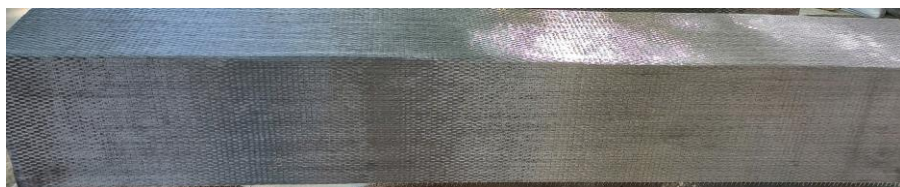
Hình 2.13 Dán tấm FRP lên bề mặt các dầm
