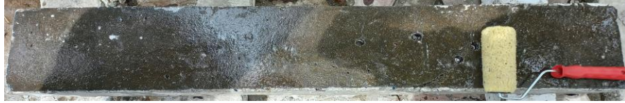
Hình 2.10 Lăn phủ lớp keo epoxy TCK 510P lên bề mặt các dầm
