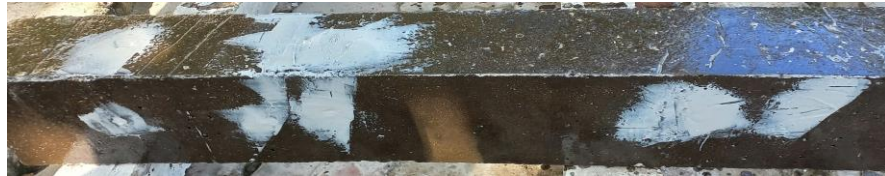
Hình 2.11 Lăn phủ lớp keo epoxy TCK 1401 lên bề mặt các dầm
