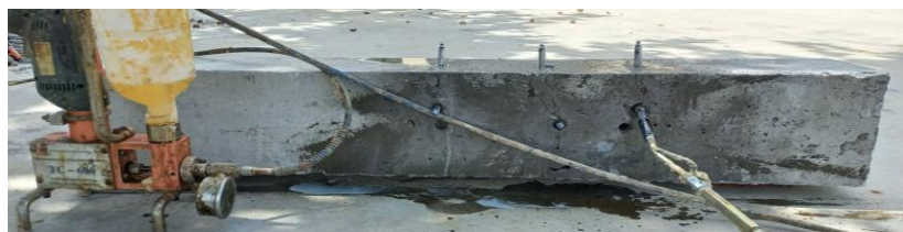
b) Bơm keo epoxy E500 vào vết nứt cho các dầm
